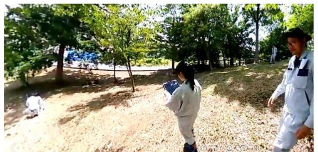
図4: LiDAR 搭載タブレット測量 協力: 前川建設
