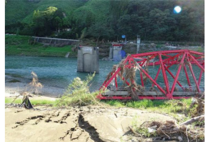
豪雨被害（相良橋）
