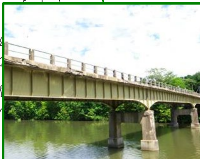
A橋（1953年建設）
