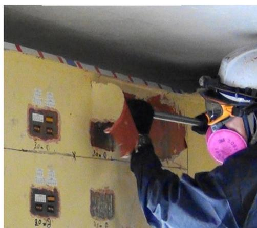
図4 塗膜剥離状況
