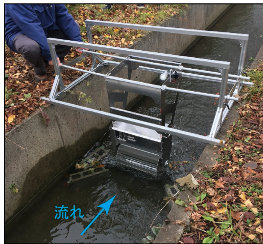
図10 水路に設置された水車システム
